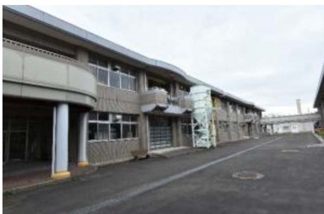
③ 3号館実習棟（運動場側から撮影）
