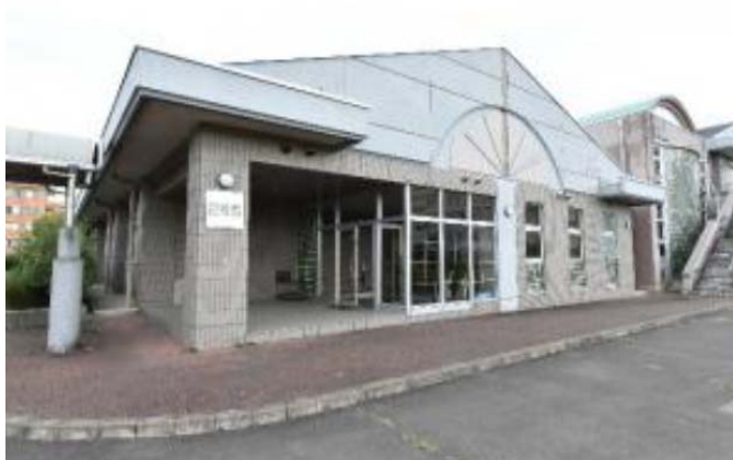
② 2号館実習棟（運動場側から撮影）
