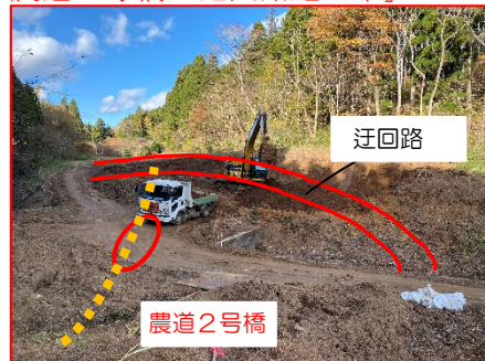
農道2号橋「迂回路施工中」
