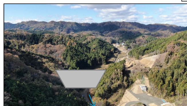
ダム建設位置
