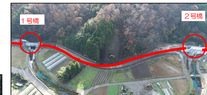
道路改良工事(1号橋~2号橋区間)
