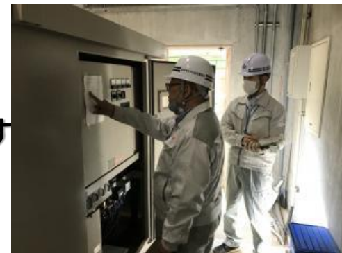
ダムの機械設備の検査の様子
