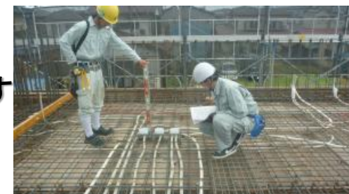
石巻好文館高校舎改築工事の段階確認の様子
