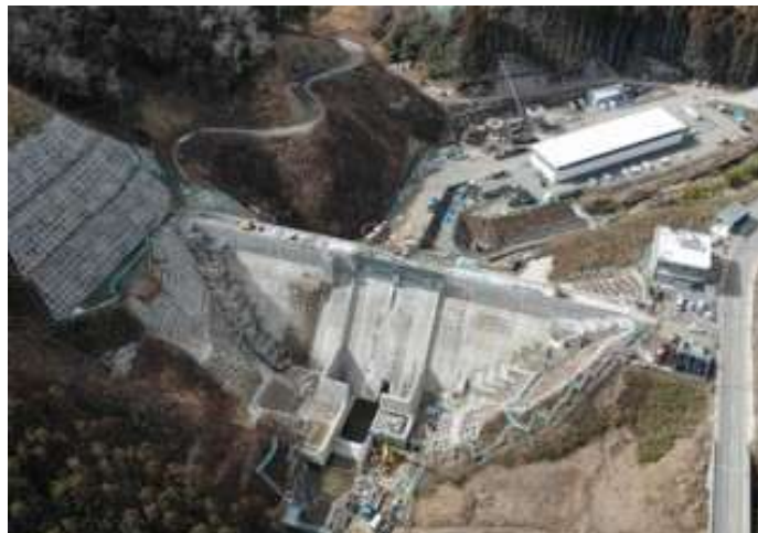
川内沢ダム 建設工事 (名取市)
