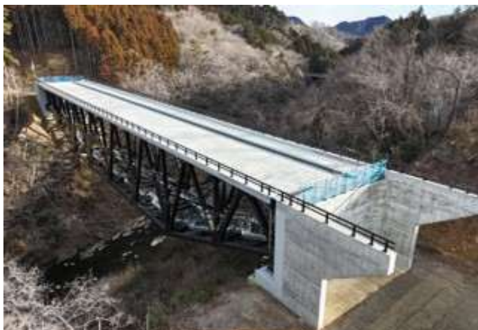
国道286号 支倉道路改良工事 (川崎町)
