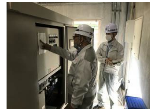
ダムの機械設備の検査の様子
