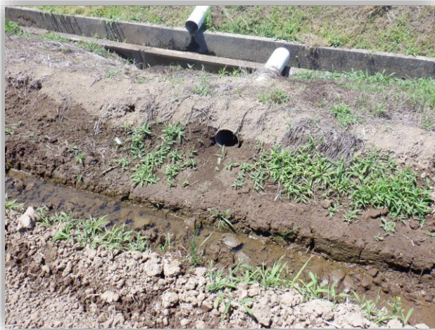
写真 明きよと落水口が接続されているほ場 (左)、明きよが施工されたほ場 (右)
