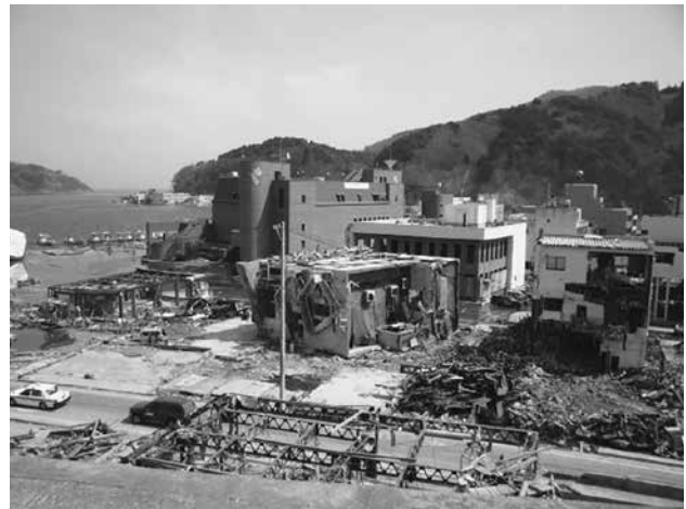
女川町内の被害状況（平成23年4月）
