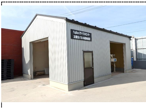
廃太陽光パネルリサイクル施設 外観
