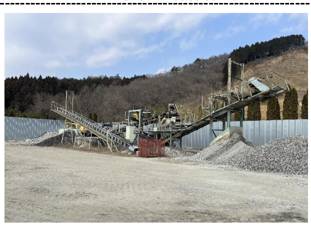
主な処理後物・製品保管施設
