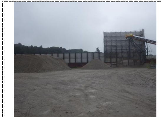
主な処理後物・製品保管施設
