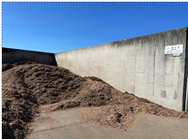
主な処理後物・製品保管施設
