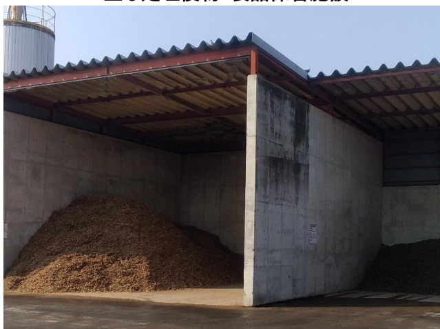
主な処理後物・製品保管施設
