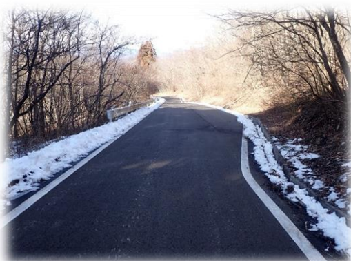
完成した大谷地線の様子
