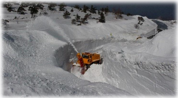
除雪車によって雪を掘り下げ徐々に雪の壁が造られます
