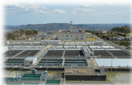
南部山浄水場
