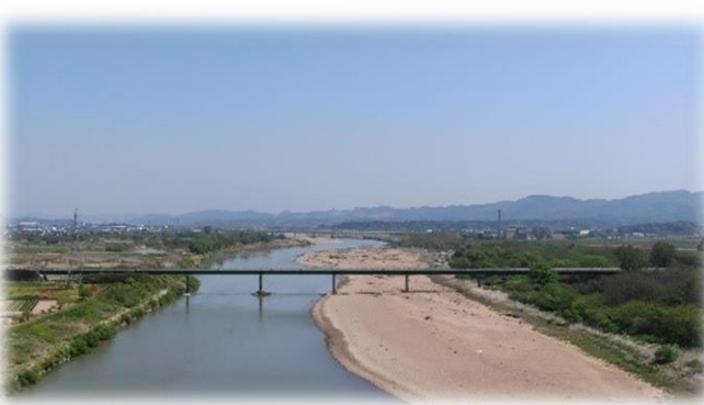
応急復旧工事 角田市道「枝野橋」
