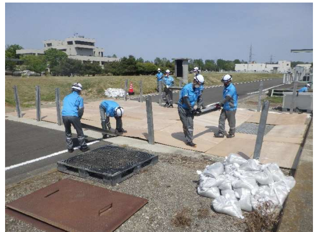
道路横断バイパス水路組立作業
