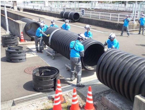
パイプバイパス水路設置作業
