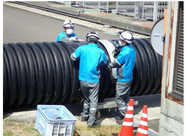
パイプバイパス水路設置作業
