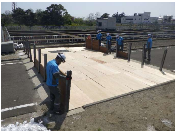
道路横断バイパス水路組立作業
