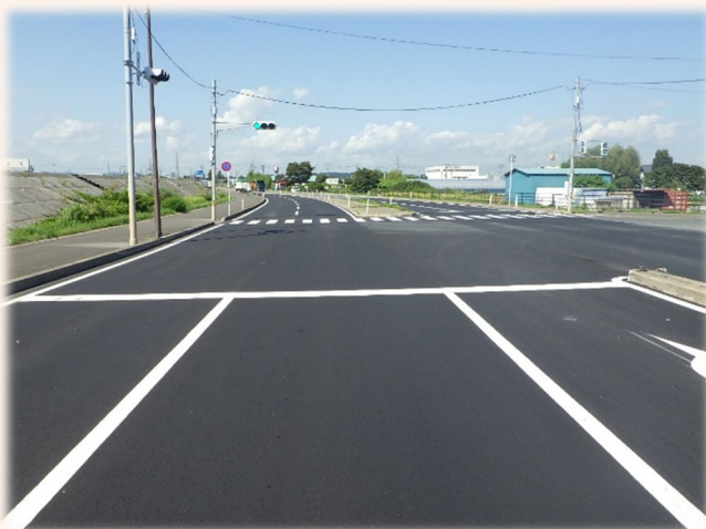
赤井舗装補修工事 【令和7年度完成】
