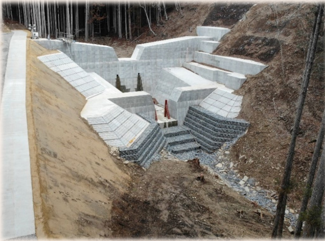
会の沢堰堤砂防メンテナンス工事 【令和7年度完成】
