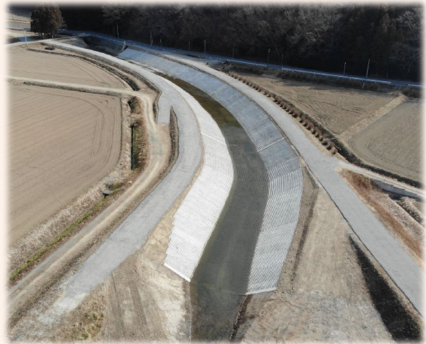
真野川河川改修事業 【令和7年度完了】
