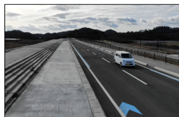
【自転車走行空間整備】
