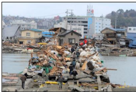
【(国)398号・東内海橋(津波被災直後)】
