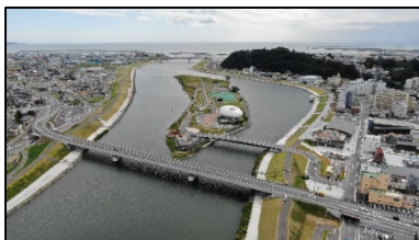
【(国)398号・内海橋】
