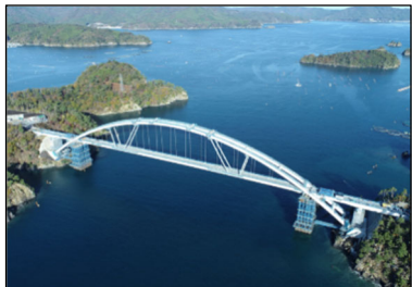
【町道出島線・出島架橋本体架設】
