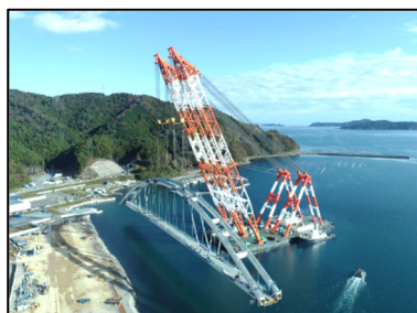
【出島架橋・中央径間浜出し（R5.11月）】
