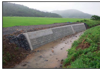
【水沼川（破堤箇所復旧）】
