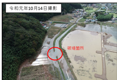
【富士川（破堤状況）】
