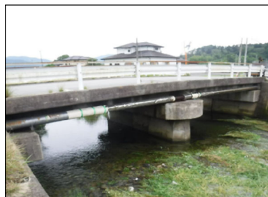
【(主) 北上津山線・大沢橋架替】
