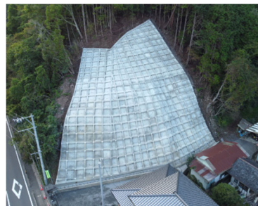
【⑤小滝急傾斜地対策】
