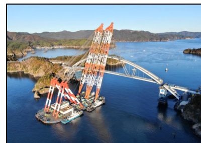
【出島架橋・中央径間架設（R5.11月）】
