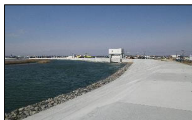
【定川・河川災害復旧】
