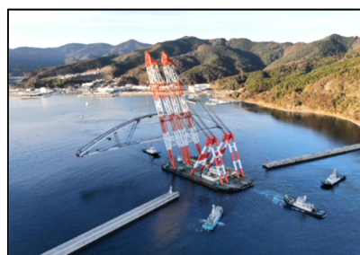
【出島架橋・中央径間曳航（R5.11月）】
