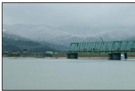
【(国)398号・新北上大橋(上部工流出)】
