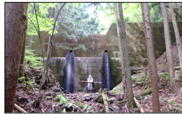
【会の沢堰堤砂防メンテナンス】
