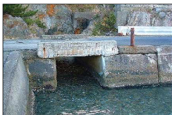
【盆ノ沢橋梁長寿命化】
