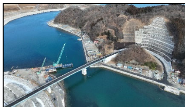
【(一)釜谷大須雄勝線・尾の崎橋】
