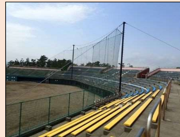
野球場スタンド（老朽化に伴う修繕）
