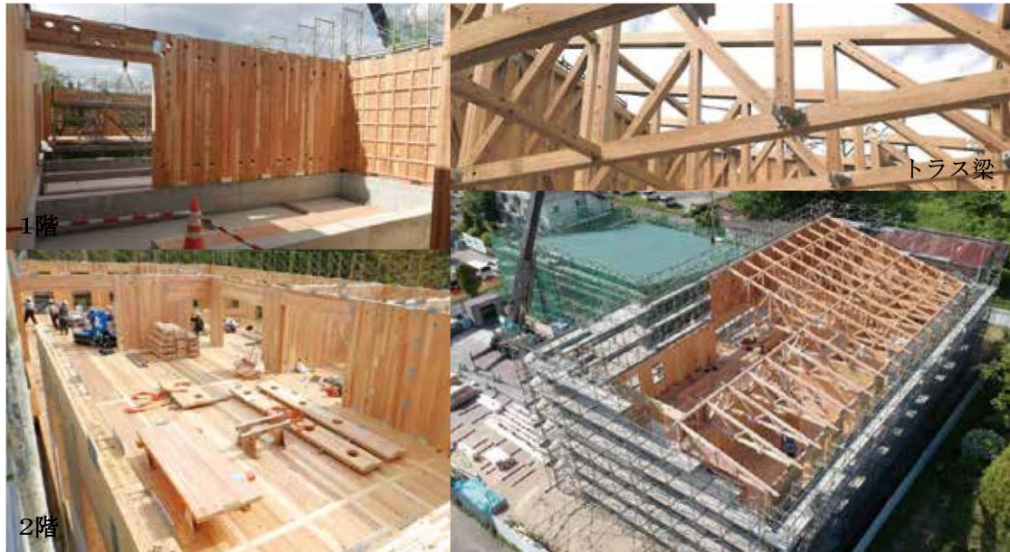
※1・2階壁（15cm厚）と2階床（21cm厚）は全てCLTパネル、トラス梁は現場組立
