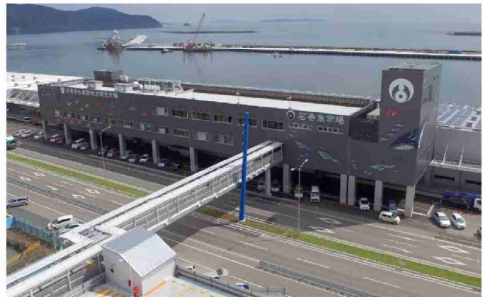
石巻市水産物地方卸売市場石巻売場
