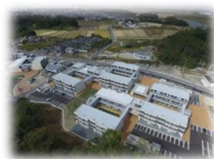
七ヶ浜町 菖蒲田浜地区 (平成27年9月完成)
