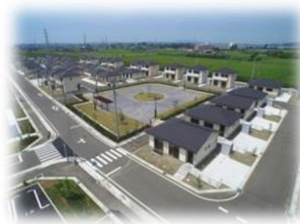
東松島市赤井柳の目北地区 (平成27年7月完成)
