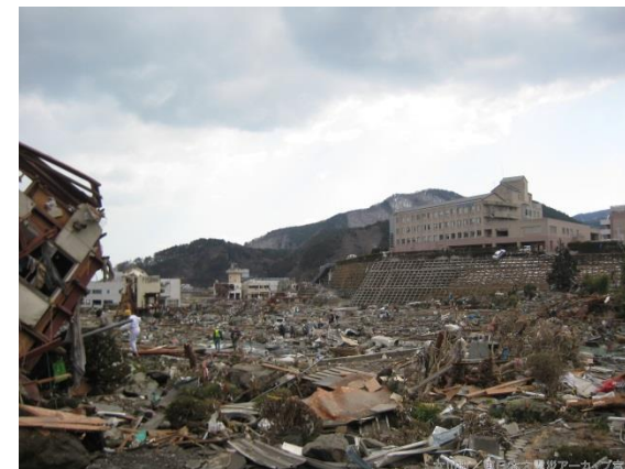
女川町の被害状況
