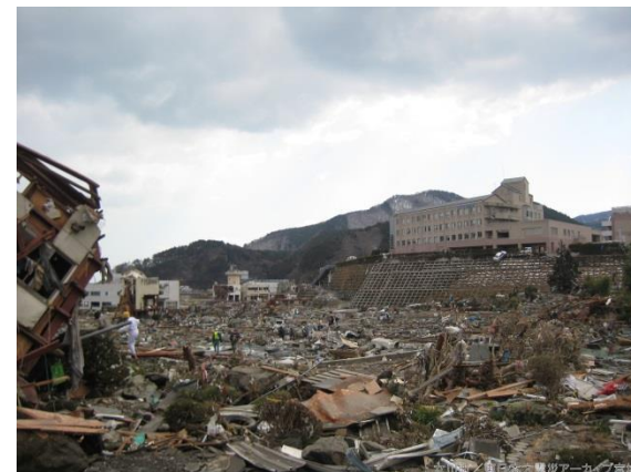
女川町の被害状況
