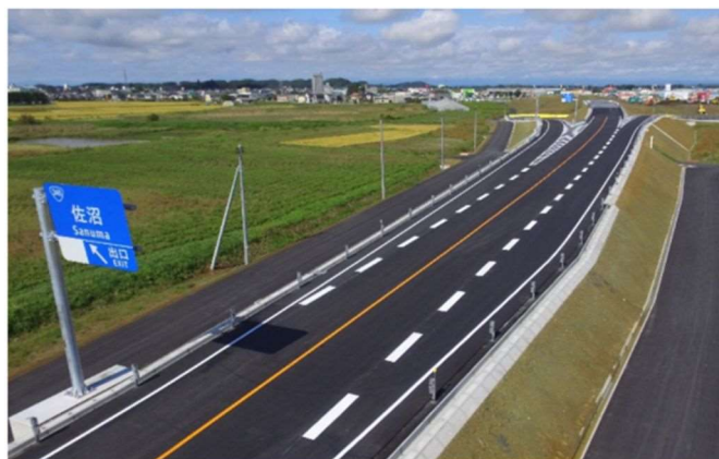
みやぎ県北高速幹線道路
