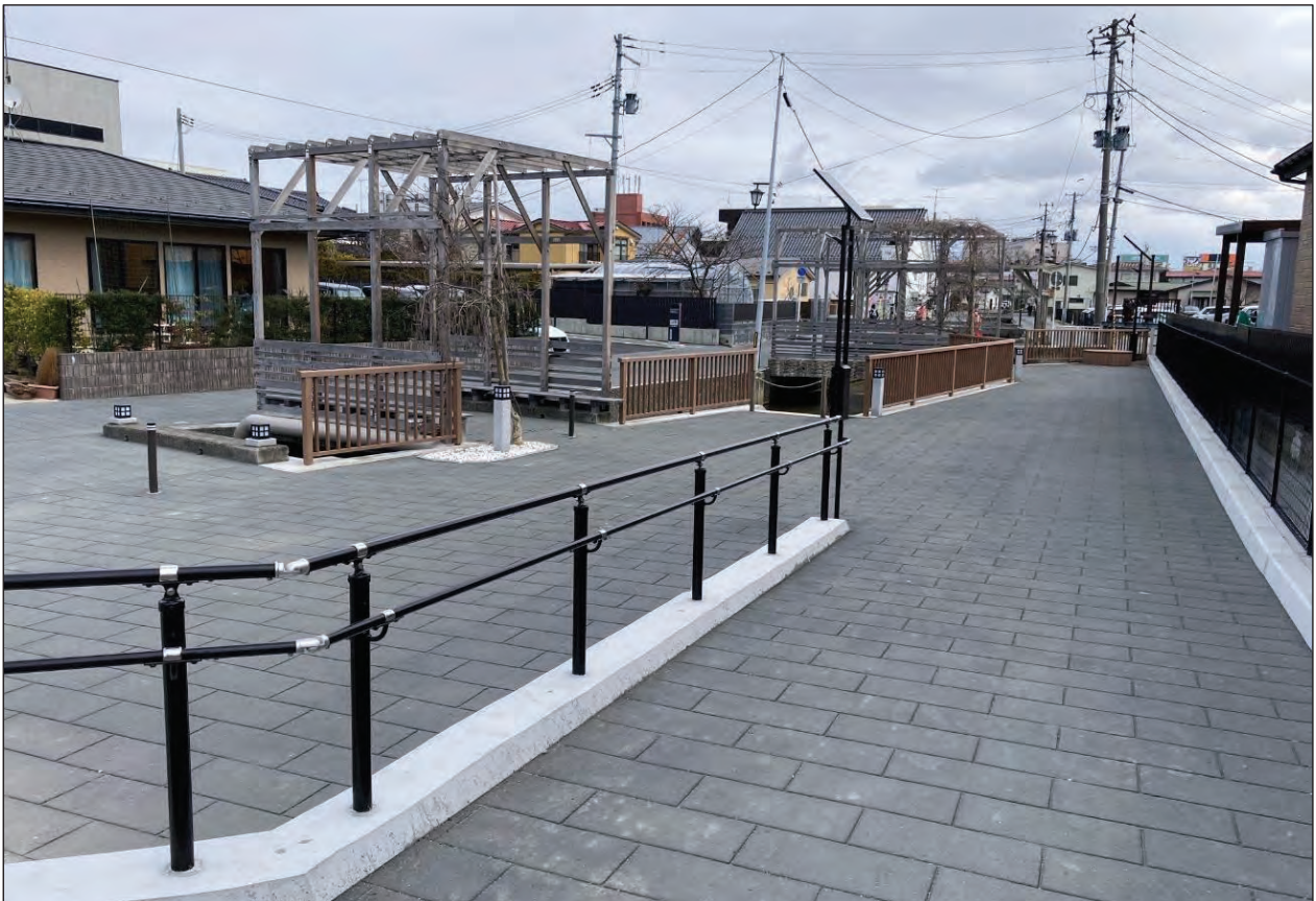
石畳舗装 整備後
