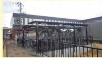
<整備後 (駅西駐輪場：北側)>
