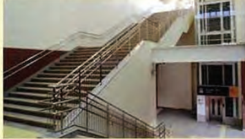
<整備後（自由通路東口階段）>
