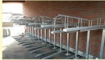
<整備後 (駅東駐輪場：北側)>
