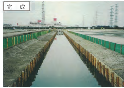
②仮設水路工事
