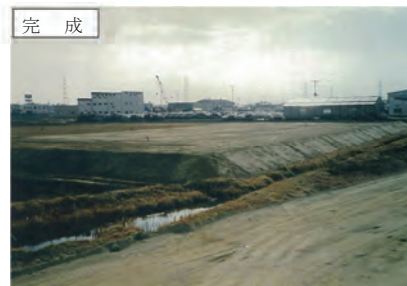
③1街区 整地工事
