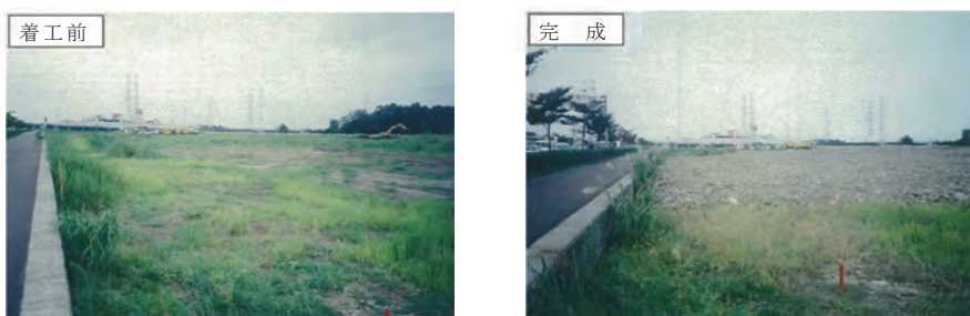
② 16 街区 整地工事
