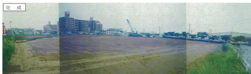
①48街区 整地工事
