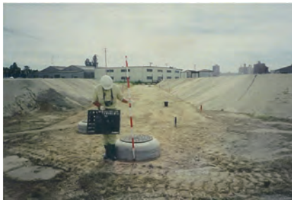
③区画道路 6-25 下水道工事(雨水)
