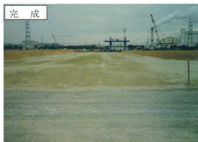
②ポートセンター南線 道路築造工事
