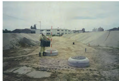
④区画道路 6-25 下水道工事(汚水)
