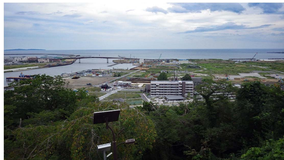
②日和田山から見た新門脇地区の整備状況(H29.9月撮影)
