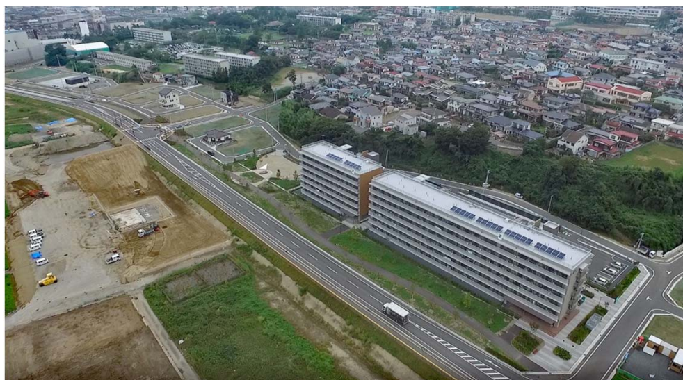
①完成した南光湊線(西側区間)と復興公営住宅(H29.9月撮影)
