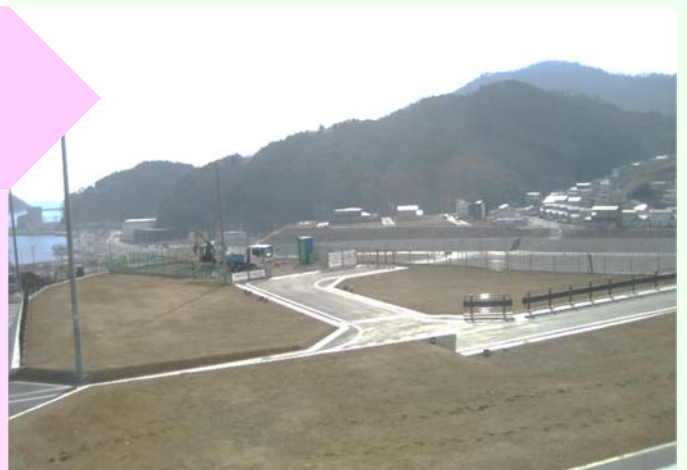
写真 女川町堀切山地区
