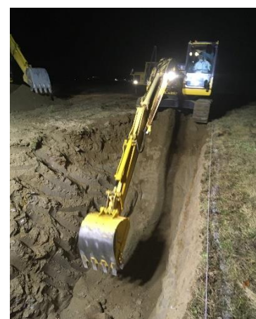
〔豚を埋却するための掘削の様子〕
