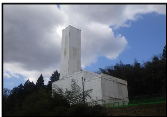
写真: 2段階目の密閉養生の全景
