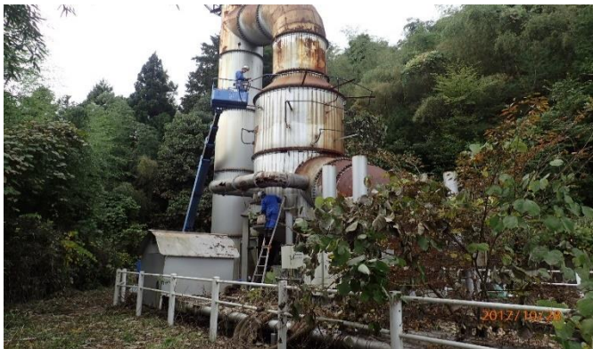
▲ 焼却施設の老朽化等調査を実施しました。現在結果の取りまとめを行っています。
