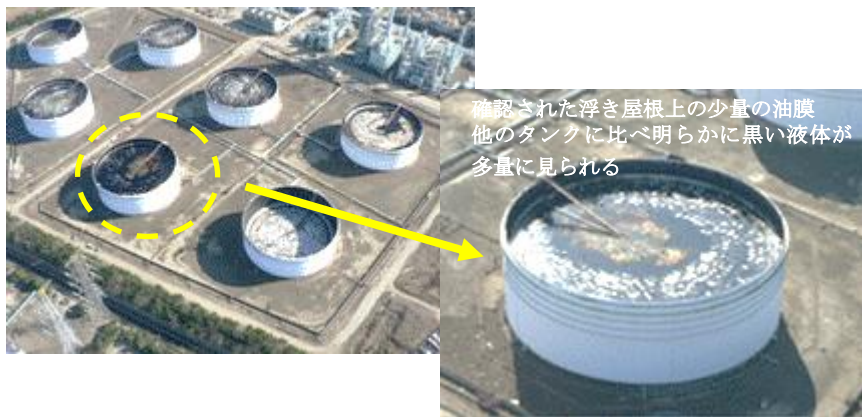
図 2.5.1 浮き屋根上に原油溢流疑いの事例
