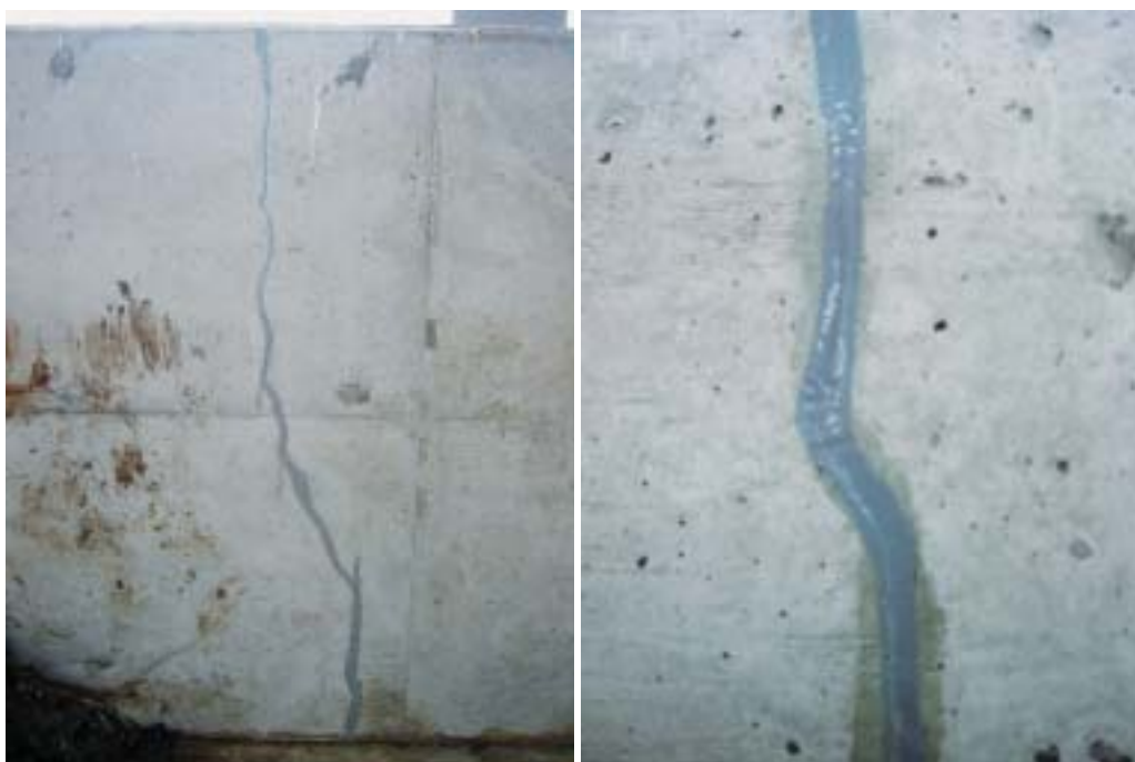
ヒビ割れの補修例
