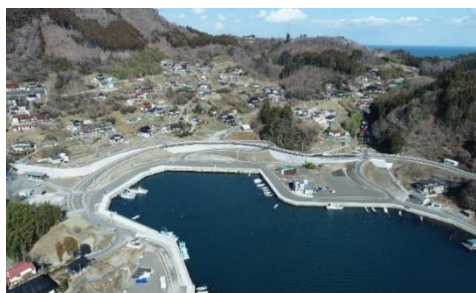
鮎立漁港海岸(鮎立地区) R6.3月完成
