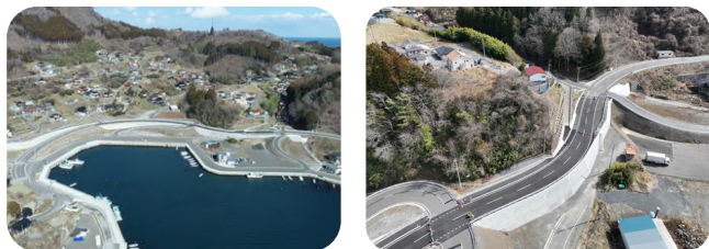
鮪立地区に整備した鮪立漁港海岸
