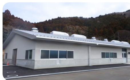
新設された閉鎖循環式陸上養殖研究棟
