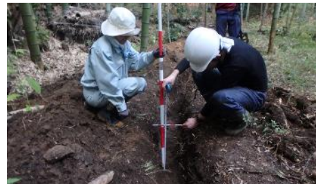
【東電との作業間打合せ(上)と完成状況(下)】
