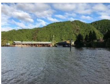
【津山町「道の駅」浸水被害状況】
