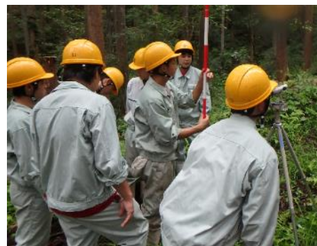
【作業道の縦断勾配を計測】
