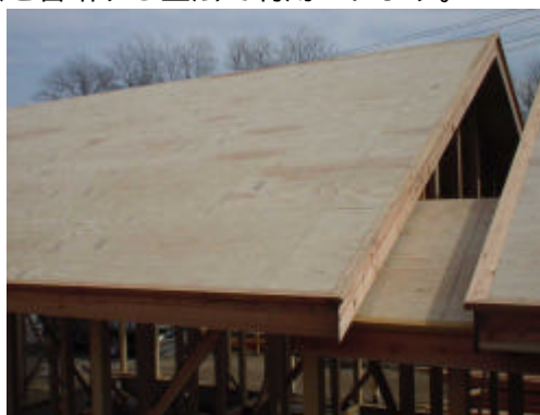
スギ合板の屋根野地板施工例（石巻市内）
