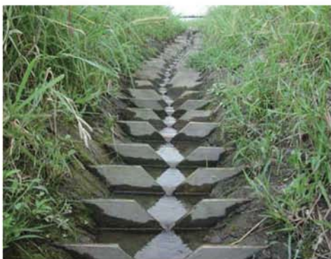
写真-2 土水路を利用した水田魚道
