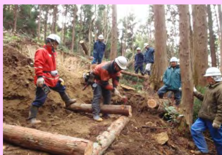
支障木を利用して路肩を補強する
