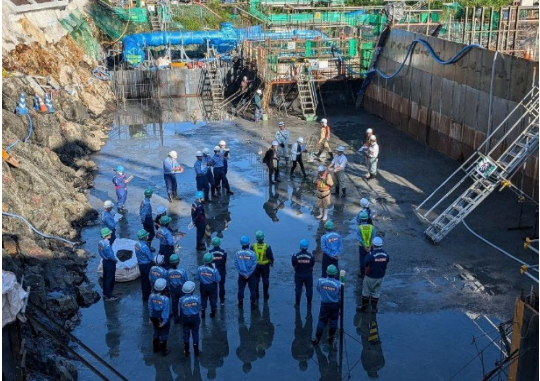
川内沢ダム見学会（東北地方整備局）
