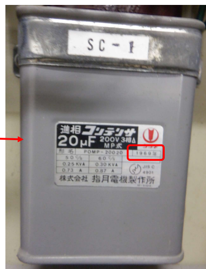
低圧進相コンデンサ拡大 (1969年(S44)製)
