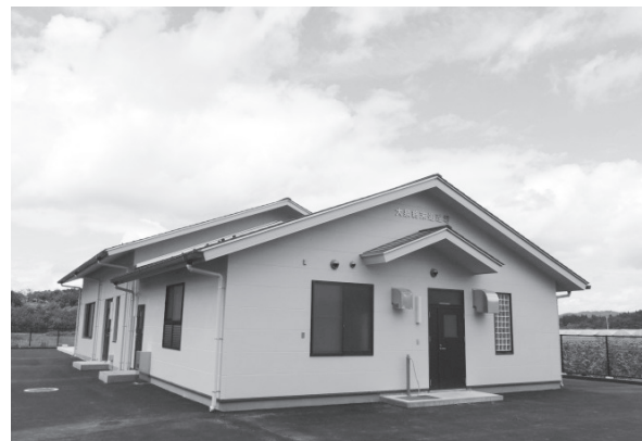
▲大泉地区汚水処理施設（登米市）
