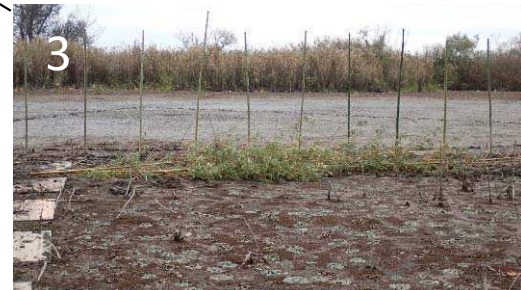
3. 竹竿で造成したエコトーン(1.0ha) R4造成.
