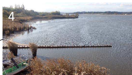
4. 板柵で造成中のエコトーン(1.3ha) R5に造成.
