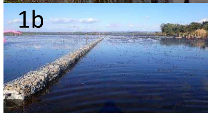
1. 植生マット(1a)や蛇籠(1b)で造成したエコトーン(1.0ha) R2~R5に造成.
