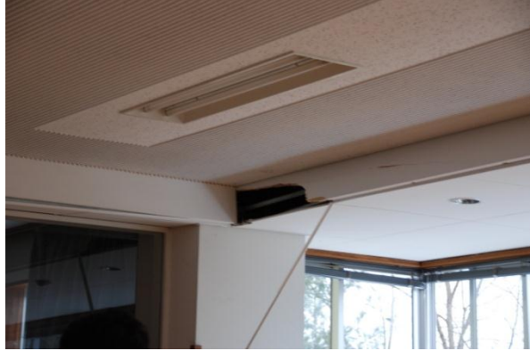
④階段床のずれ
