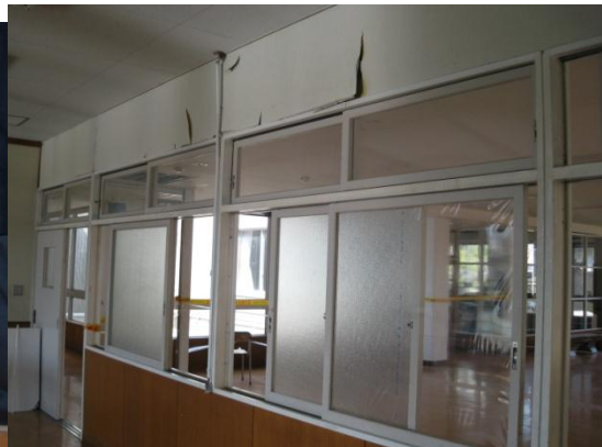
⑥廊下の壁破損
