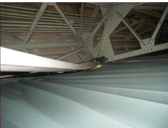
⑥床の沈下 (写真右側に傾斜)
