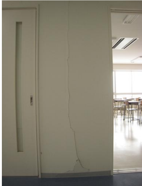
校舎③ 6階選択教室スライディングウォール破損及び周辺壁面破損
