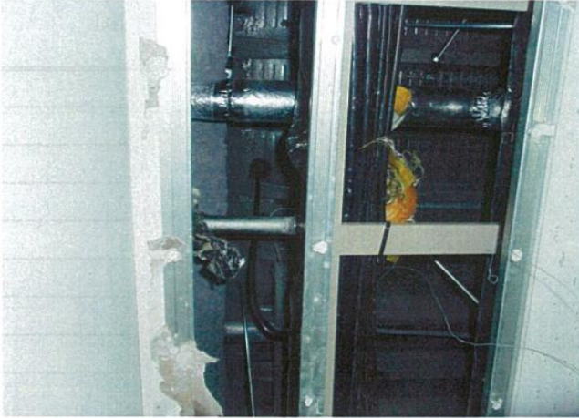
校舎② 7階被服室前天井ボード破損
