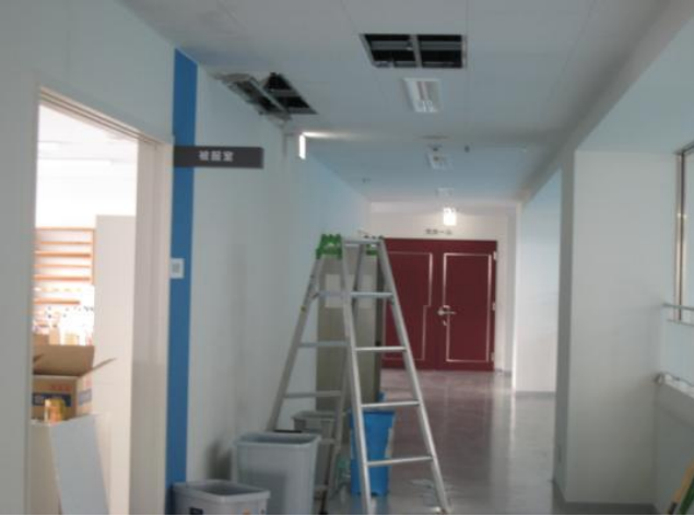
校舎② 7階被服室前天井ボード破損
