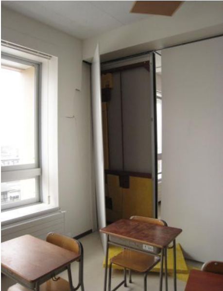
校舎③ 6階選択教室スライディングウォール破損及び周辺壁面破損
