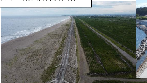
仙台市：荒浜海岸防災林
