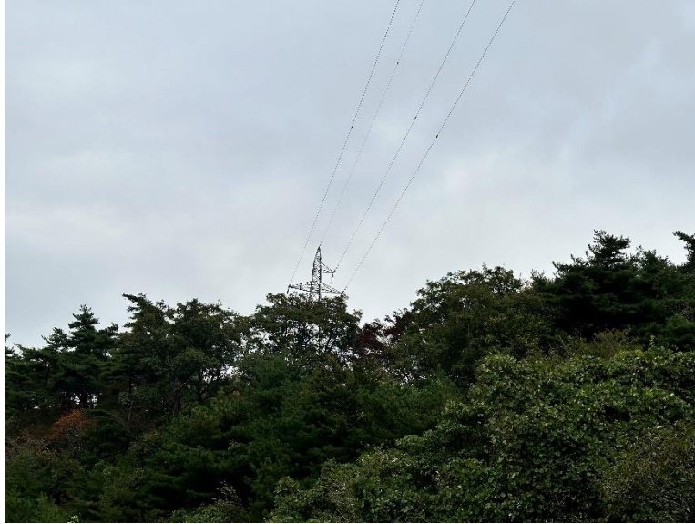
①高圧線下及び近隣区域の現況
