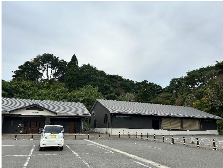
③町営駐車場の状況
