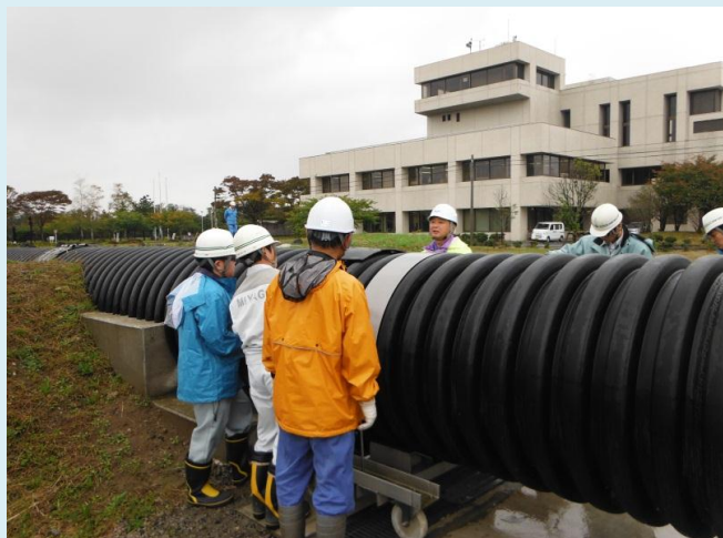
接続カバー取付作業
