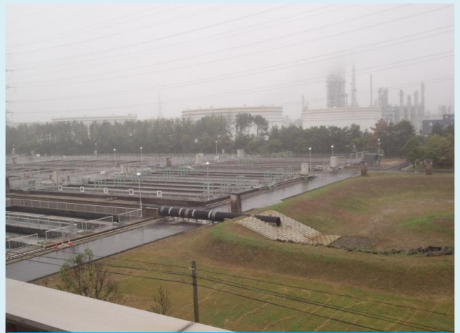
バイパス管接続完了
