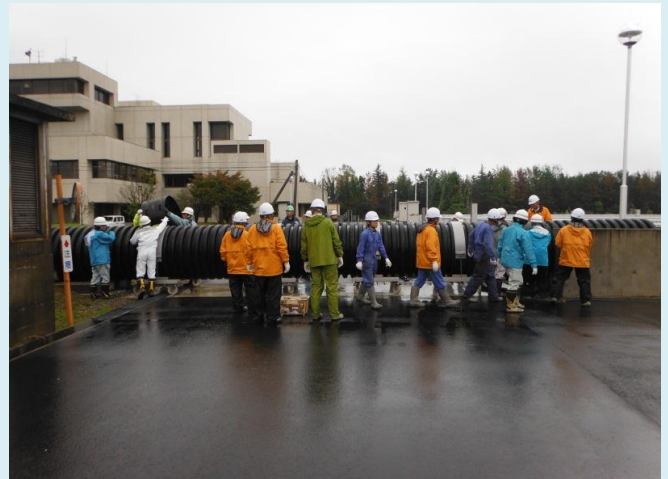
接続カバー取付作業
