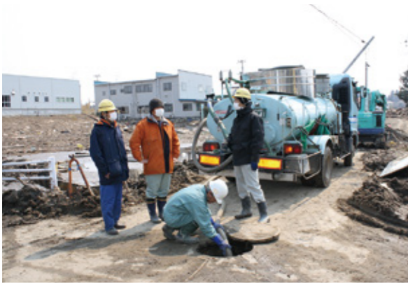
山元町下水道管からの汲み取り (山形県支援)
