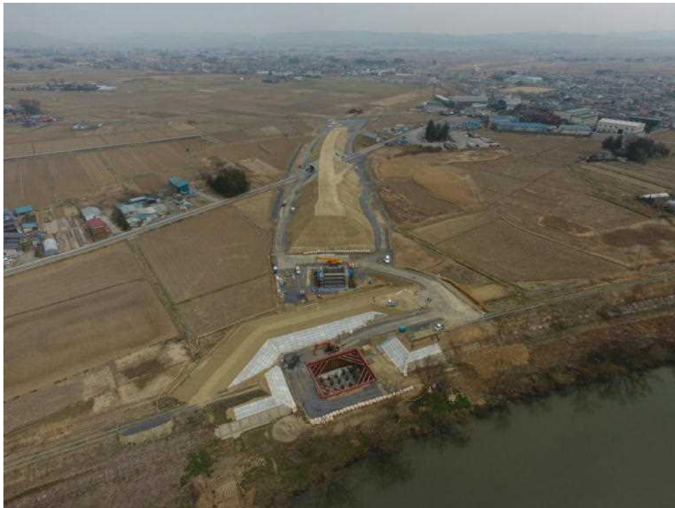
紫雲山大橋（迫川左岸）架橋予定位置
