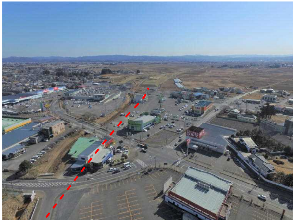
終点部：加賀野高架橋（佐沼 I C 付近）架橋予定位置
