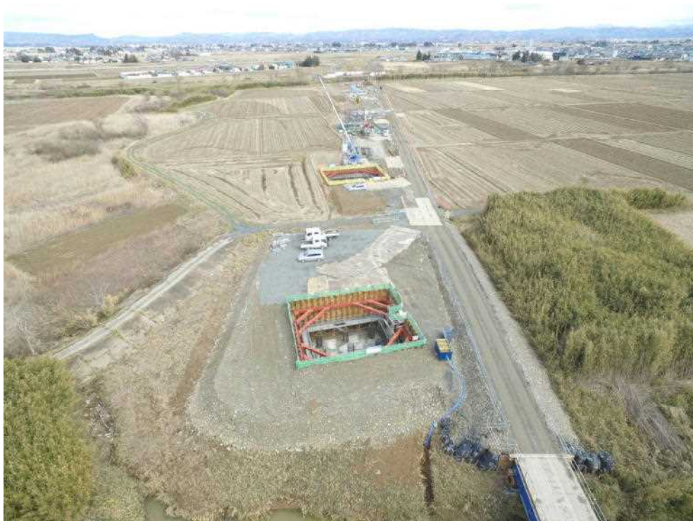
紫雲山大橋（荒川・迫川間高水敷）架橋予定位置
