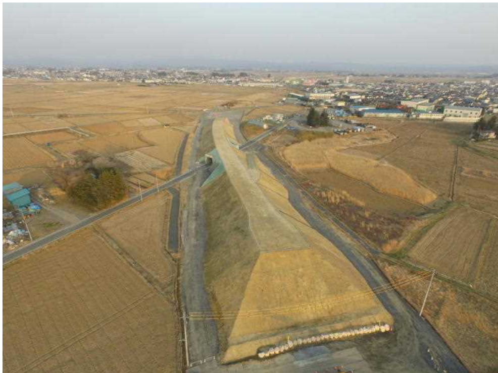
紫雲山大橋・加賀野高架橋間（迫川左岸）市道交差位置
