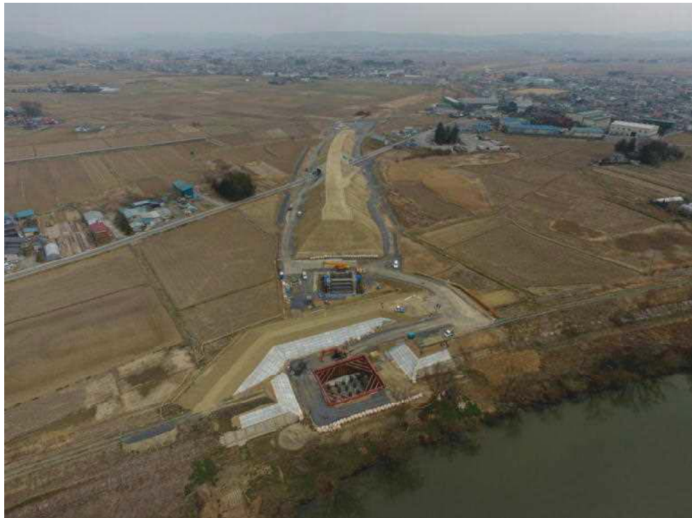
紫雲山大橋（迫川左岸）架橋予定位置
